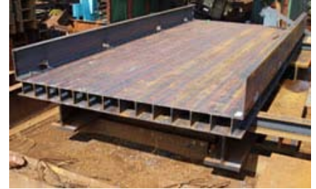
簡易工事桁製作
