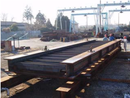
橋梁工事桁製作・組立
