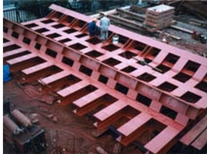
地下鉄工事用シールドマシン発進架台製作
