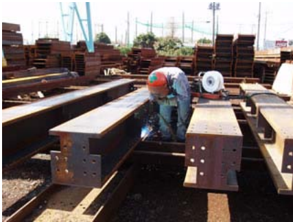
桁スティフナ溶接
