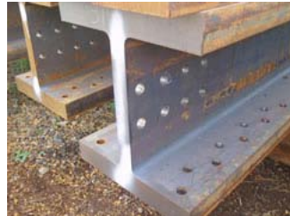
極厚H型鋼ボルトジョイント
