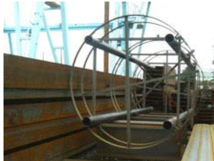
構真柱ガイドリング製作
