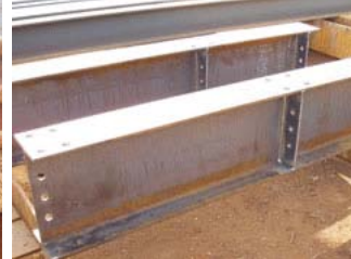
梁 ガゼット溶接
